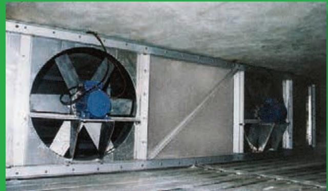
конструкция вентиляционного блока (корпус из алюминиевого сплава)
